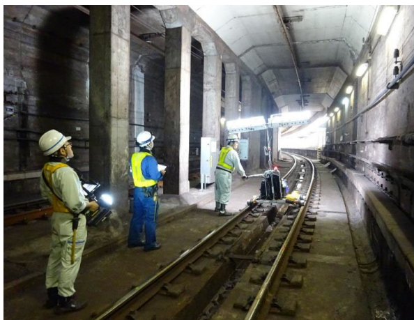
写真-1 トンネル検査
