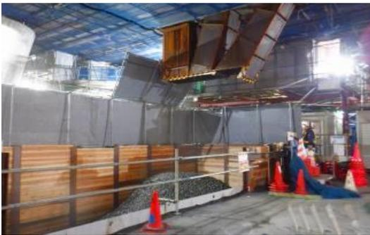
写真-5 バラスト撤去作業（本設桁下）
