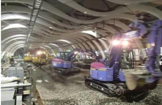
写真-4 バラスト撤去作業（開口投入）
