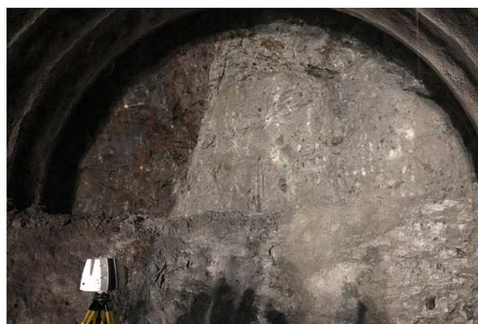
図-2 リアルタイム計測状況（掘削直後）
