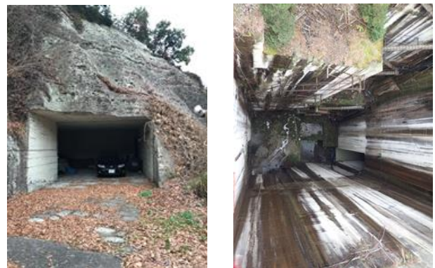
図-1 大谷採石場の入口の例(左：矩形断面の横坑，右：矩形断面の立坑)
