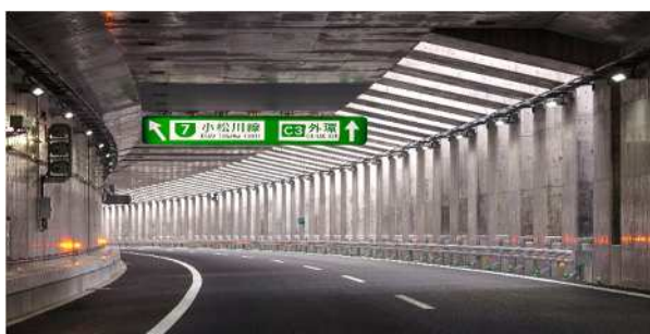
写真-2 半地下（掘割）区間
