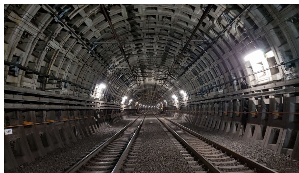
写真-10 トンネル上部
