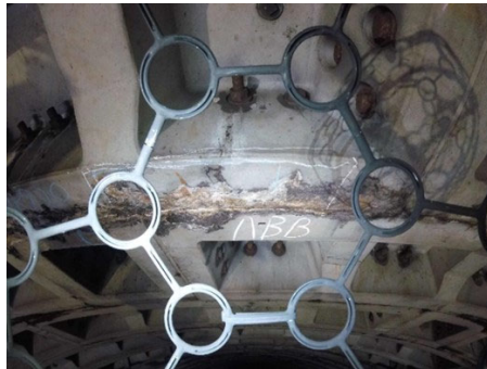
写真-12 ドローンで撮影した画像
