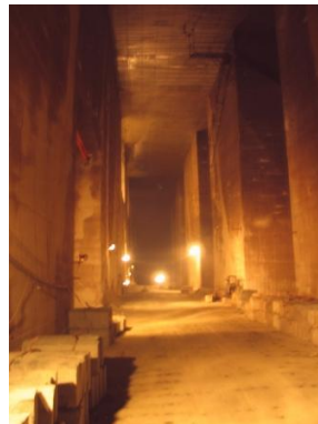
図-1 対象とした大谷採石地下空間の内部
