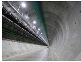
写真-3 東名側トンネル坑内状況
