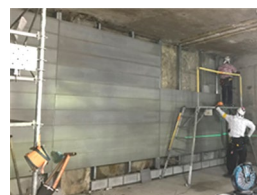
写真-5 複壁施工状況
