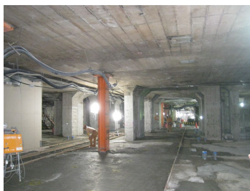
写真-3 スケルトン化完了時の状況
