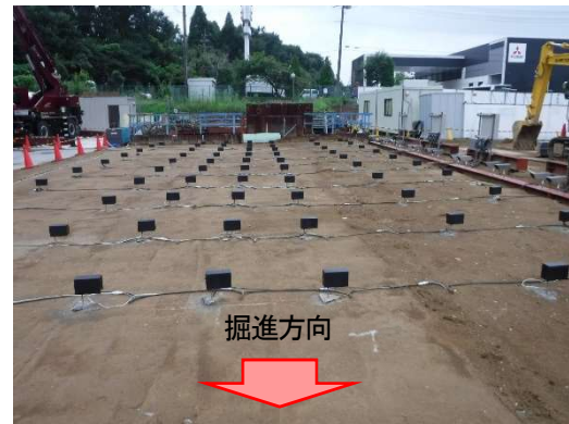
図-12 地表面変位計測状況
