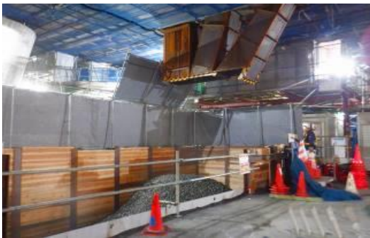
写真-5 バラスト撤去作業（本設桁下）
