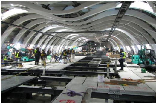
写真-3 新ホーム構築状況
