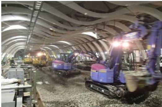
写真-4 バラスト撤去作業（開口投入）
