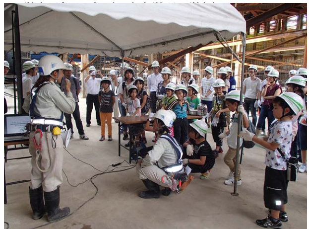
写真-2 親子見学会 現場説明状況
