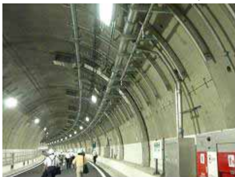
現場見学の様子（首都高・中央環状新宿線） （開通日 H19.12.22 前の見学）
